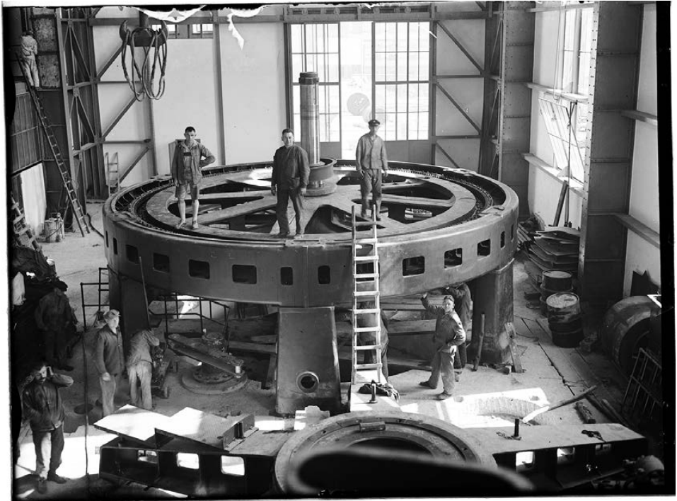
Bau der Staustufe Klingenberg 1930
